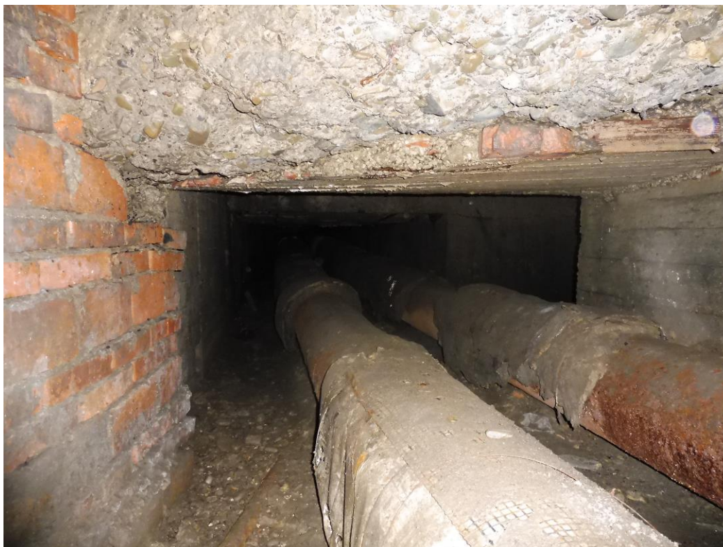
Obr.9- Teplovodní potrubí
